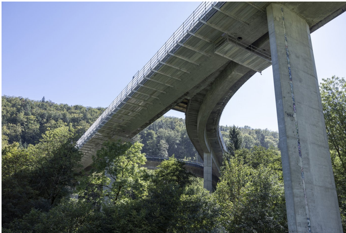
Une photo prise dans le périmètre du Parc Chasseral, à Frinvilier, sous le pont de l'autoroute en travaux. Elle fait partie de l'exposition. Monika Flückiger
